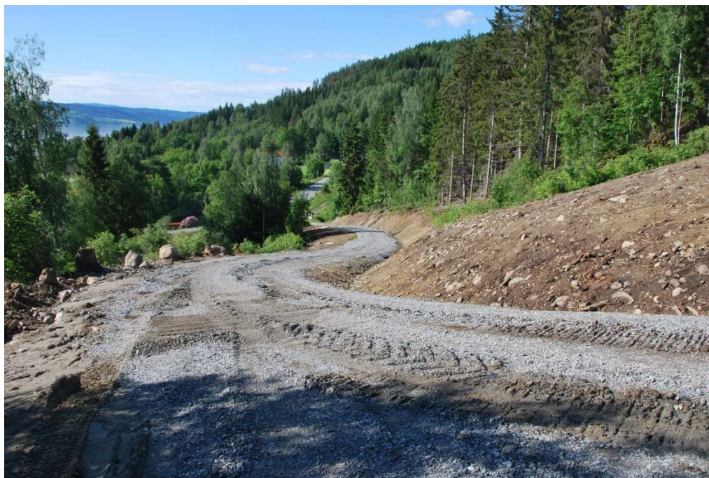
Opprustning av veg opp i Engensmarka
